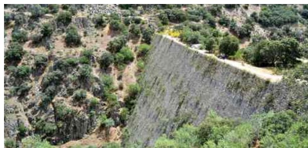
Presa del Gasco
